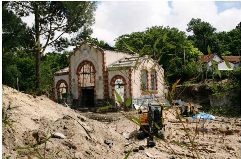
Sauvegarde de la façade du bâtiment de l'ex Cie générale des Eaux en Ville d'Hiver
